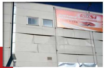
**Низкая жесткость** трехслойной конструкции панели – ненормативный прогиб от внешних воздействий
