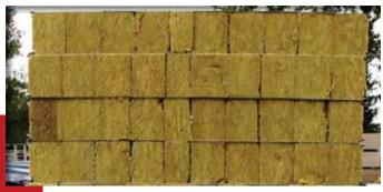
**Зазоры между ламелями** – снижение теплоизолирующей способности и пожаростойкости ограждающей конструкции в целом
