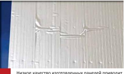
Низкое качество изготовленных панелей приводит к появлению дефектов еще в процессе монтажа
