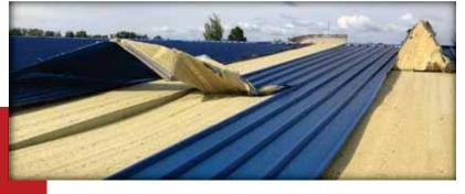
Наглядная демонстрация использования стали толщиной 0,45-0,5 мм
